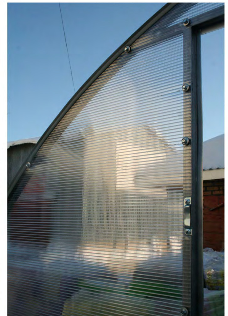
Крючок для фиксации двери в открытом положении
